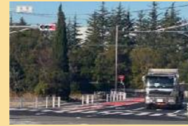
道路・交差点の新設
