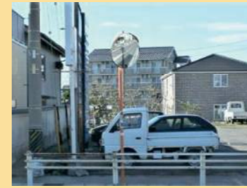
カーブミラーの設置
