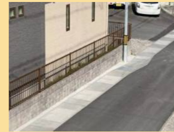
側溝整備による冠水対策
