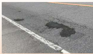
道路の穴あき補修（港南）
