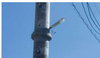
防犯灯の設置（西山町）
