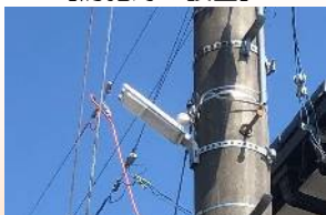
【防犯灯の設置】
